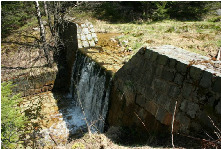
Wypełniona zapora tworzy wysoki próg – przerwana ciągłość cieku – Nadleśnictwo Szklarska Poręba. Źródło: Archiwum CKPŚ
