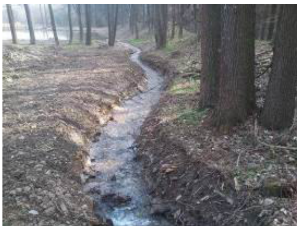
Kanał ziemny łączący 2 zbiorniki (N-ctwo Świdnica)
