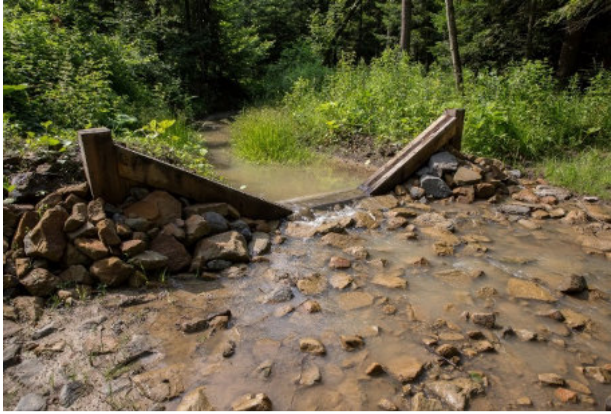
Próg powyżej brodu ukierunkowujący wodę na bród.
