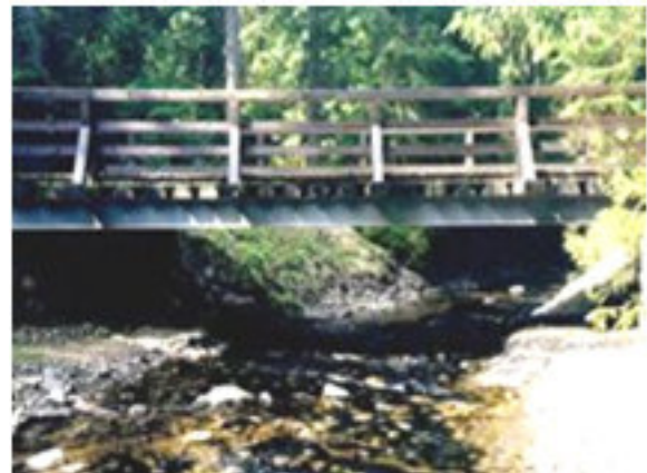
Most drewniany w TPN (fot. PRO-LAS s.c. Kraków)
