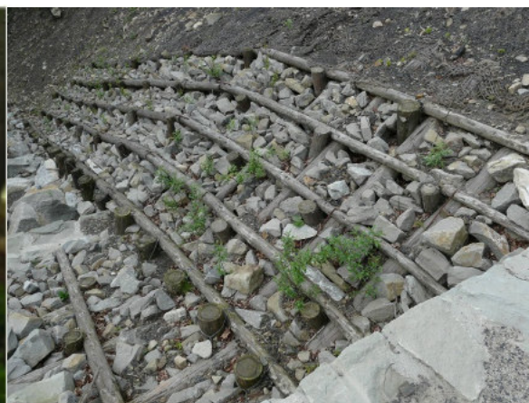
Kratownica ożywiona wierzbą poniżej brodu w Nadleśnictwie Bielsko na gruntach mineralnych szkieletowych podatnych. Źródło: Archiwum CKPŚ.
