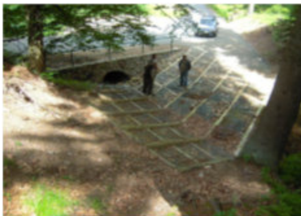
Kratownica drewniana poniżej przepustu pod drogą gminną – kratownica pełni rolę ubezpieczenia wypadu i jednocześnie brodu umożliwiającego wjazd droga leśna pod górę – Nadleśnictwo Zdroje fot. R.Majewicz
