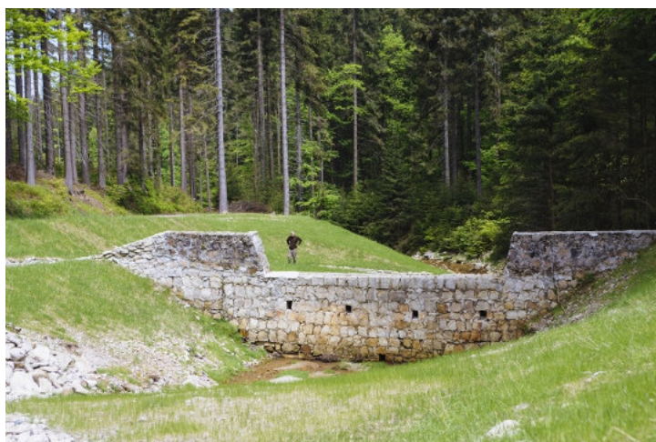
Zapora przeciwrumowiskowa w Nadleśnictwie Łądek Zdrój z oczyszczoną w ramach projektu retencji górskiej niecką (min. funkcja przeciwpowodziowa) i dobudowaną przeplawką. Zapora przerywa ciągłość transportu rumowiska - należy monitorować potrzebę alimentacji rumoszu poniżej zapory. Źródło: Archiwum CKPŚ.
