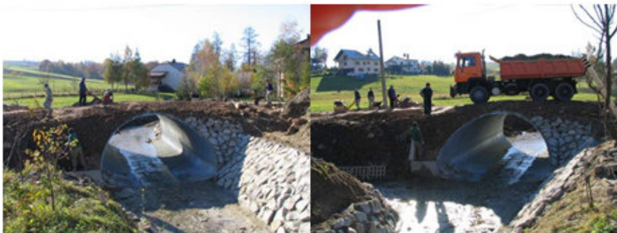
Przykłady adaptacji przepustów do zmian klimatu.
