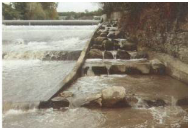
Przeławka kaskadowa przy budowlu hydrotechnicznej. (Jelonek 2008)
